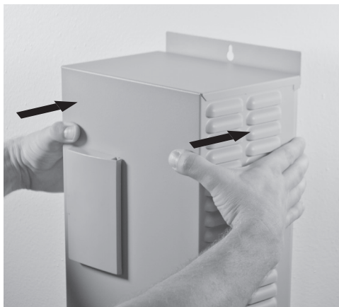
Figura 7 - Cómo volver a fijar la cubierta del Mecanismo
